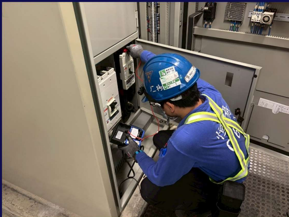
低壓設備絕緣電阻量 測
