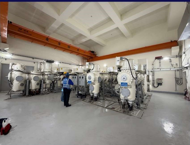
GISF6氣體取樣測試 (SO 2 ,含水量,純度,壓力)
