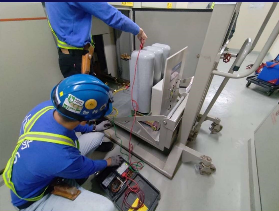
22.8KV 斷路器絕緣量測
