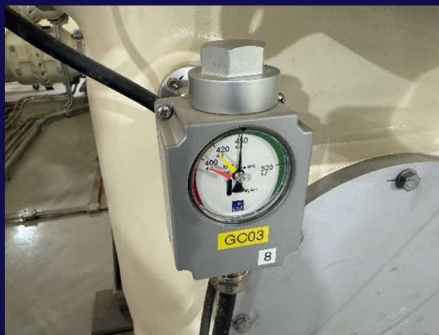
GISF6氣體取樣測試 (SO 2 ,含水量,純度,壓力)
