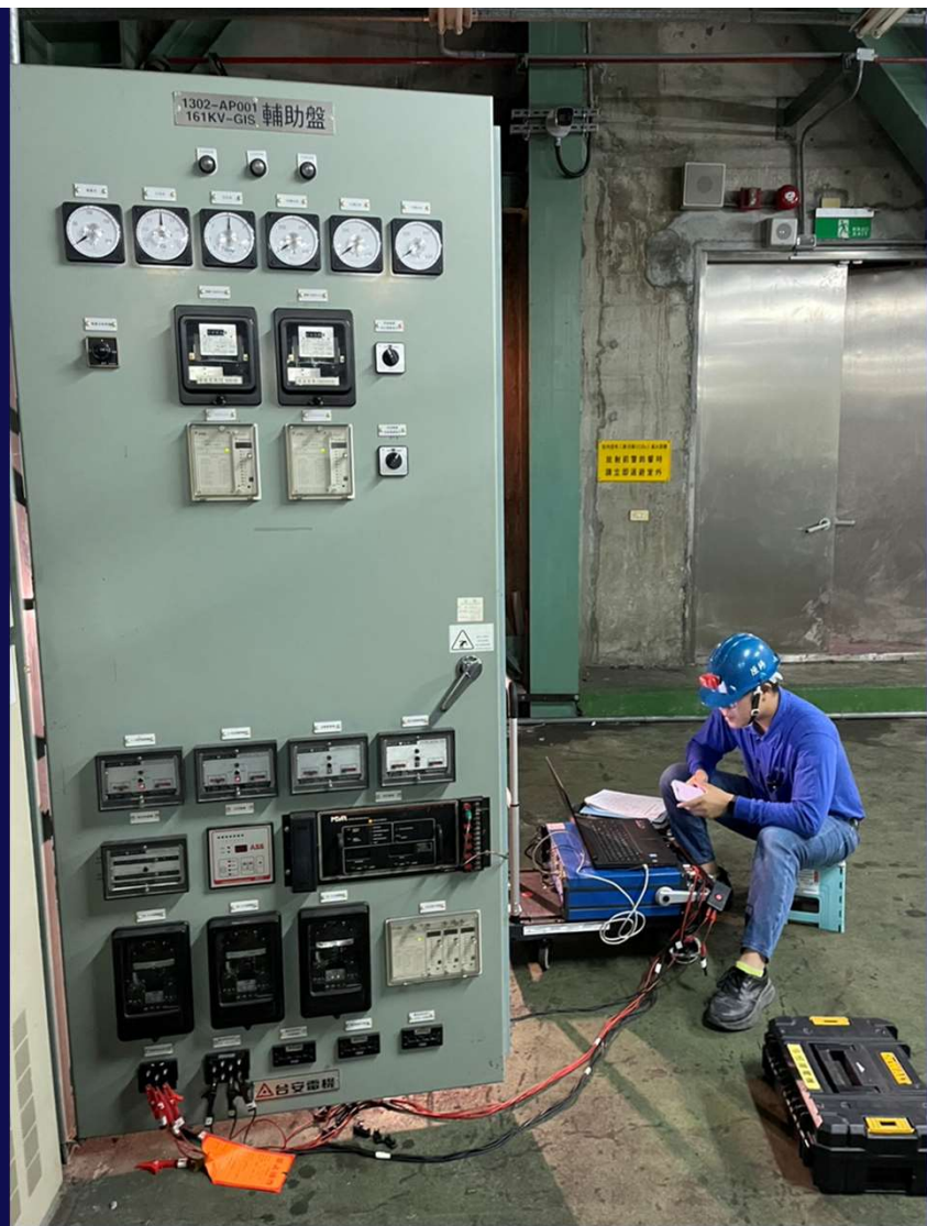
RCP盤保護電驛測試
