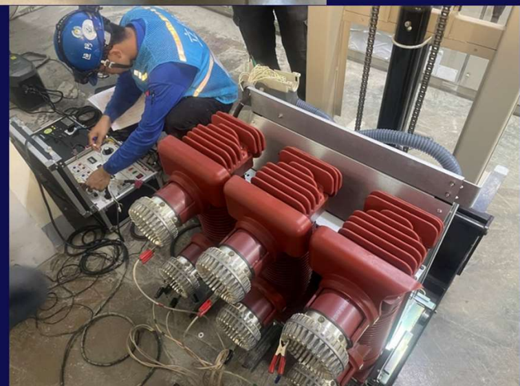
22.8KV 斷路器三相同步試驗
