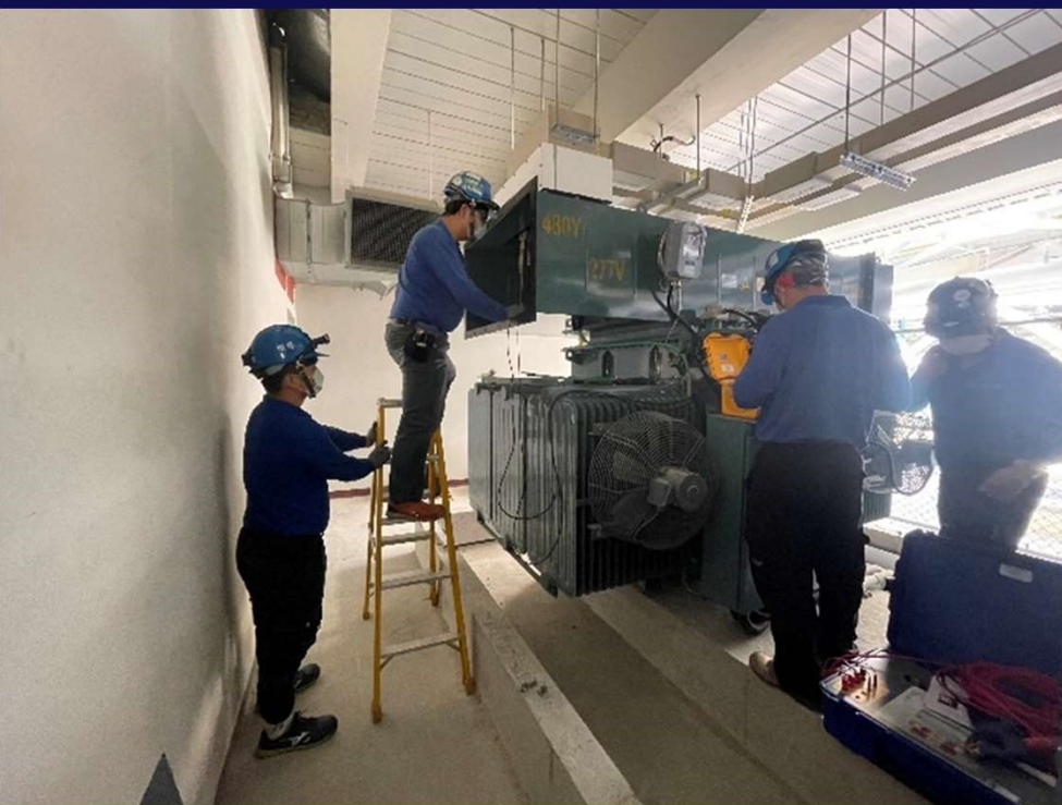
22.8KV 變壓器匝比量測
