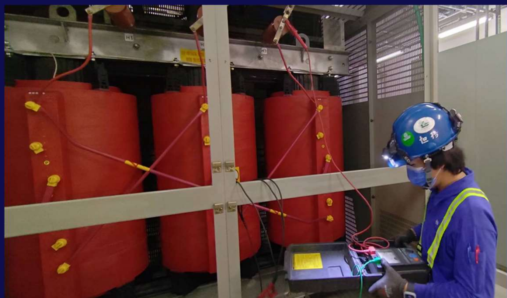
22.8KV 變壓器絕緣電阻量測
