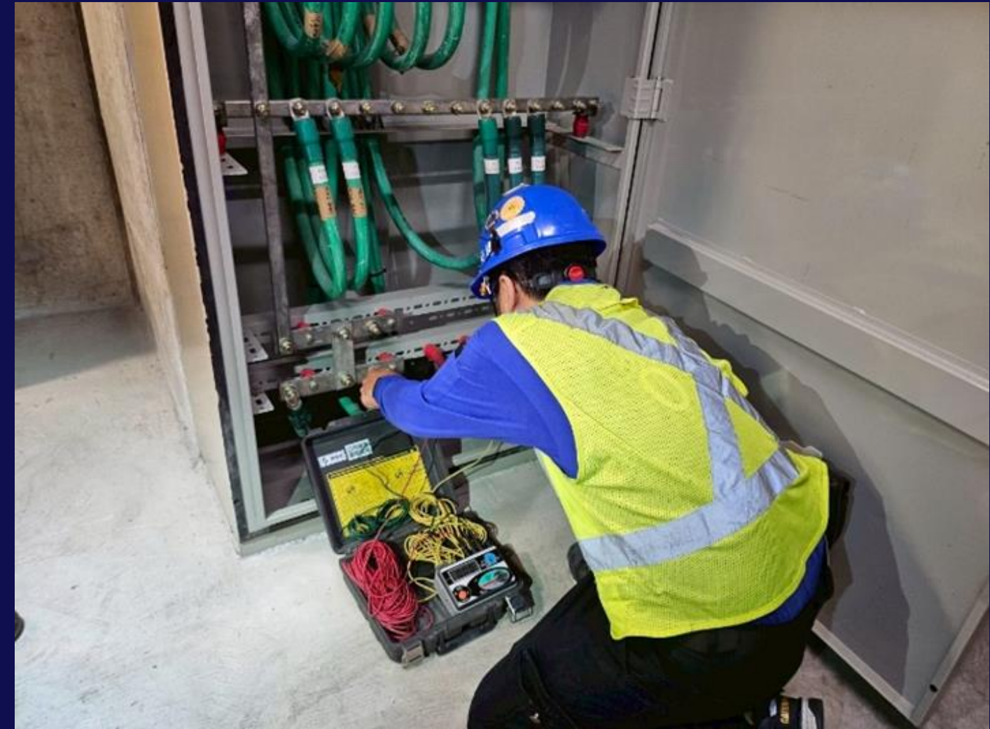
接地系統接地電阻量測
