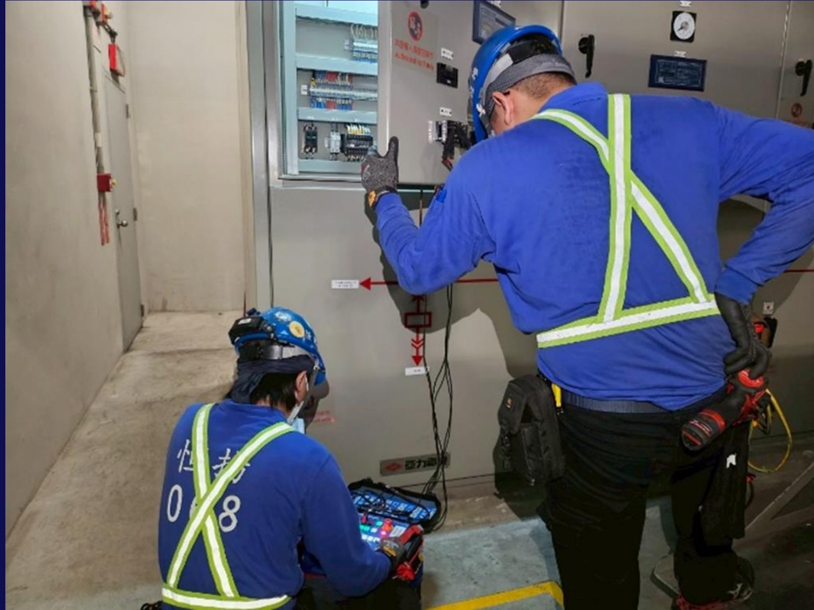
饋線保護電驛動作特性試驗
