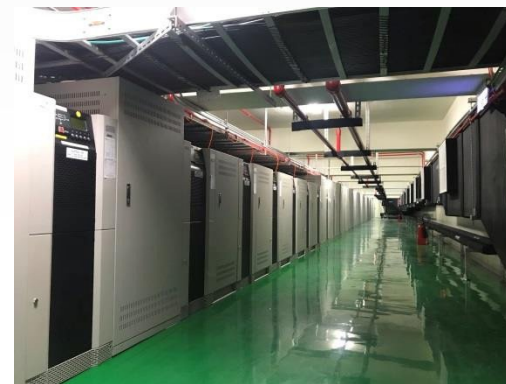
弱電系統規劃施工
