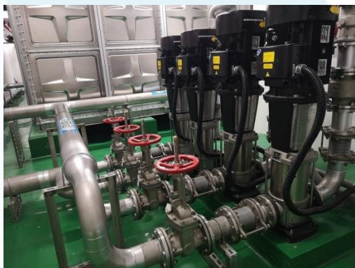
給排水系統規劃施工
