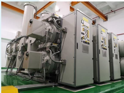
特高壓設備規劃施工
