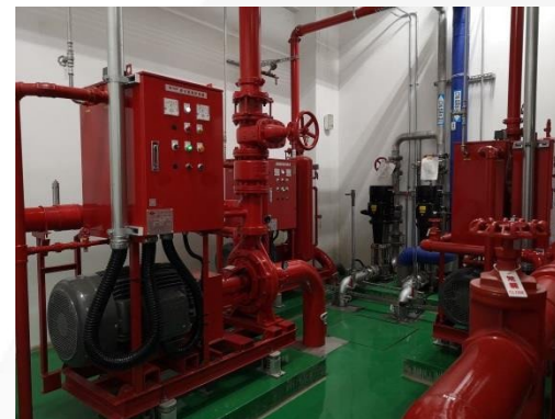
消防系統規劃施工
